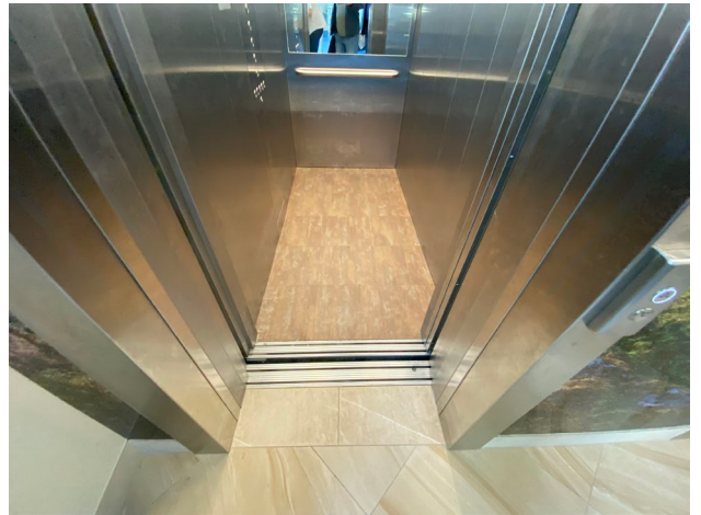
Фото № 28- Пути движения внутри здания. Лифт.
