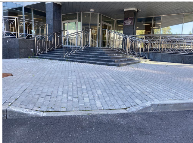
Фото №51– Запасной выход. Наружная лестница.
