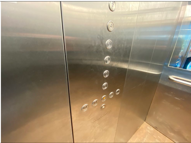
Фото №29– Пути движения внутри здания. Лифт. Кнопки дублируются шрифтом Брайля.
