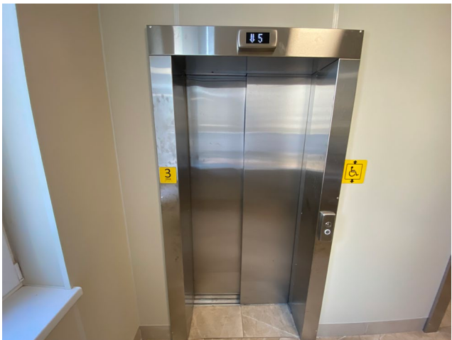
Фото № 27 – Пути движения внутри здания. Лифт. Пиктограммы.
