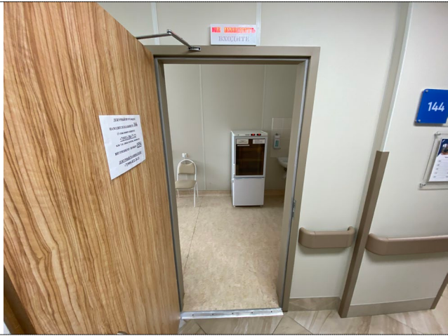
Фото №37 – Пути движения внутри здания (двери). Медицинский кабинет.
