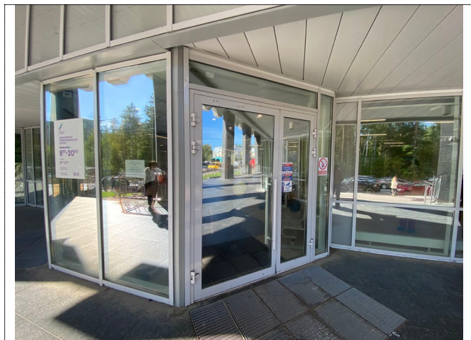
Фото № 7 – Главный вход. Входная площадка. Наружная входная дверь.
