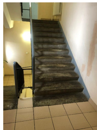
Фото № 74– Эвакуационные лестницы
