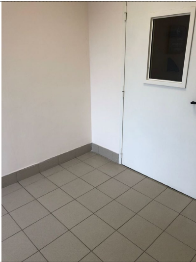
Фото №75– Эвакуационные лестницы
