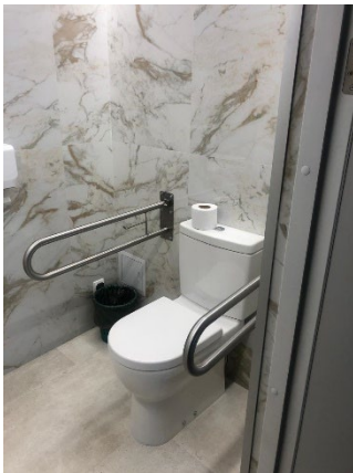
Фото №41 – Санузел в регистратуре
