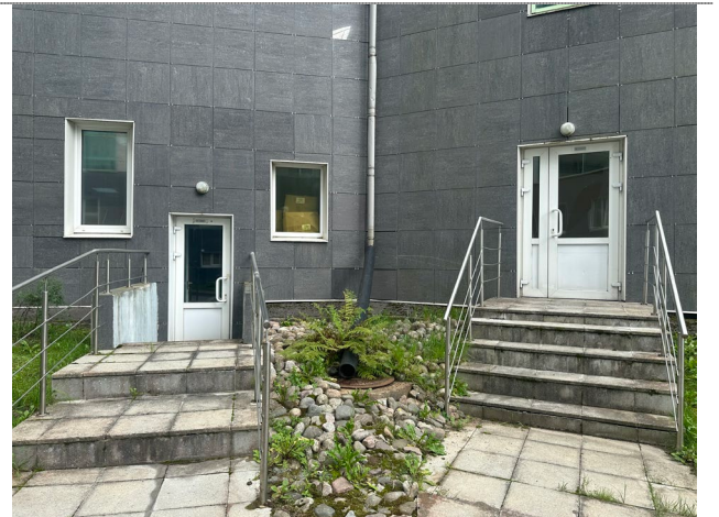
Фото № 30 – Наружные лестницы
